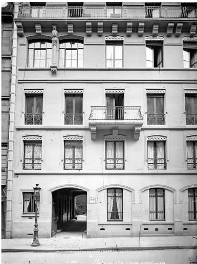
Façade du 64 rue Condorcet, Paris, 1860
