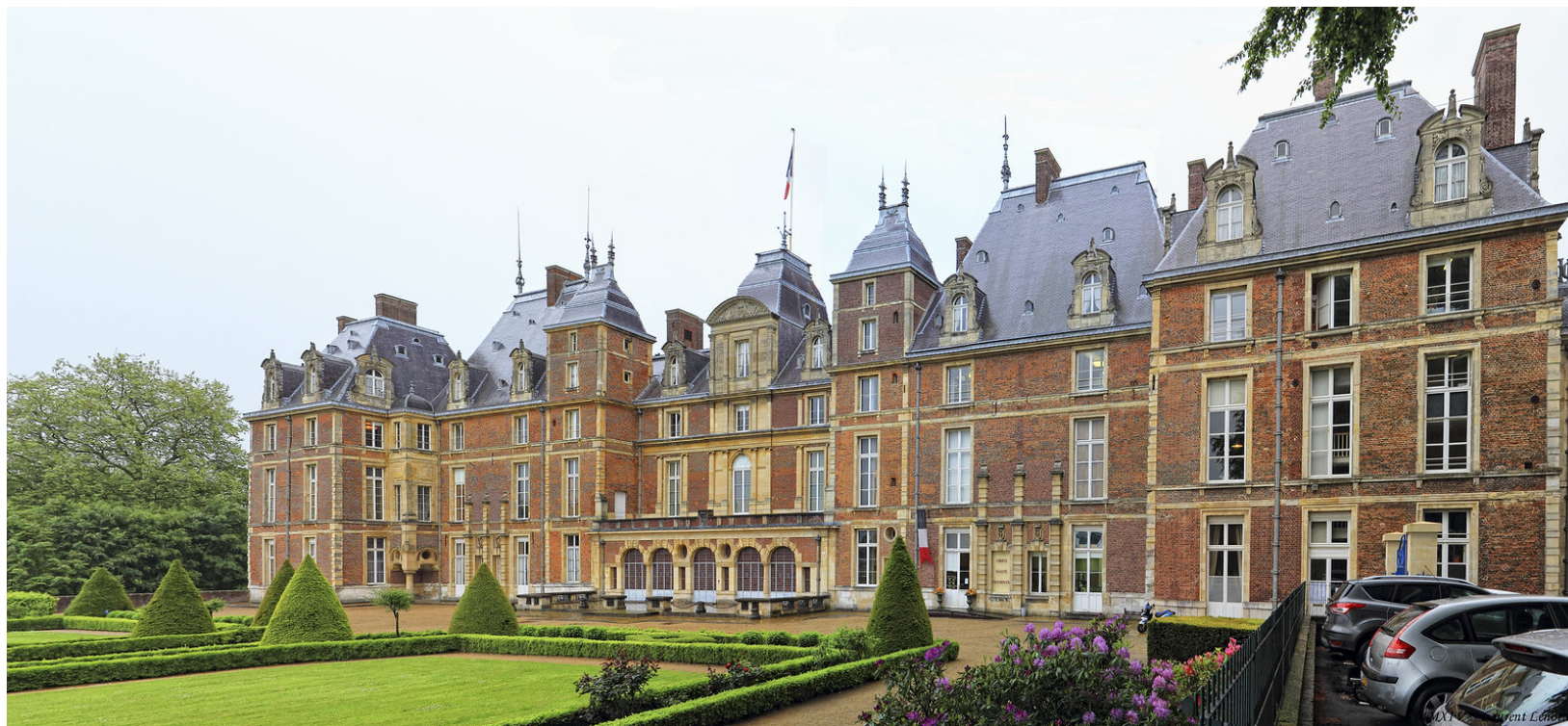
Installations du château d'Eu , Normandie, 1874
